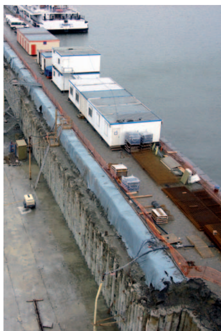
Afb. 1 'Soil mix'-wand met een grond- en waterkerende functie.
