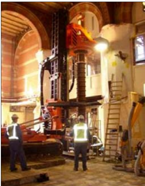
↑ Foto 2 Inbrengen van Tubex-palen met de Topdrill
