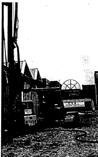
Op het terrein "Groene Vlasdam" in Lokeren is CVR bezig met het inboren van de palen
